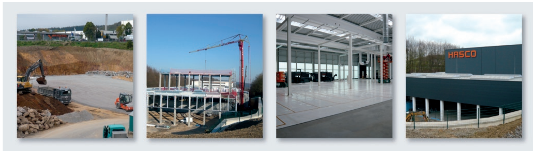
Bauprojektphasen der neuen Fertigung
